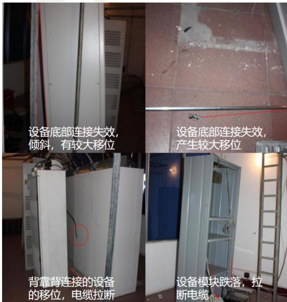
图 11 设备破坏情况
