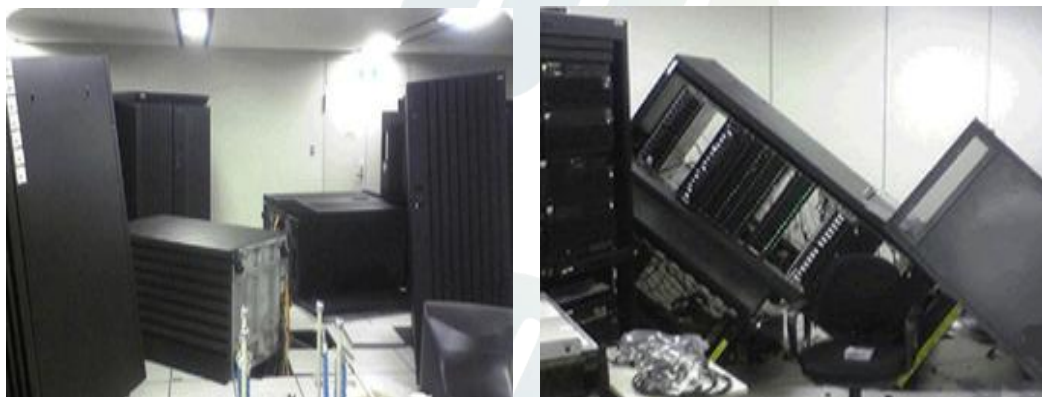
图 18 2011 年 3 月日本地震东京 IBM 数据中心受损严重 (备注：图片来自网络公开资料)
